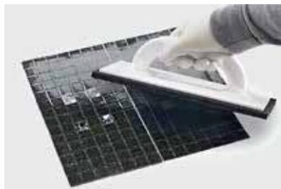
5 固化后，除去支撑纸。然后，可用柔软的橡胶刮刀为瓷砖抹灰浆。
