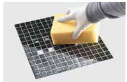
6 在固化过程中，可使用湿海绵除去溢出的接缝密封剂。
